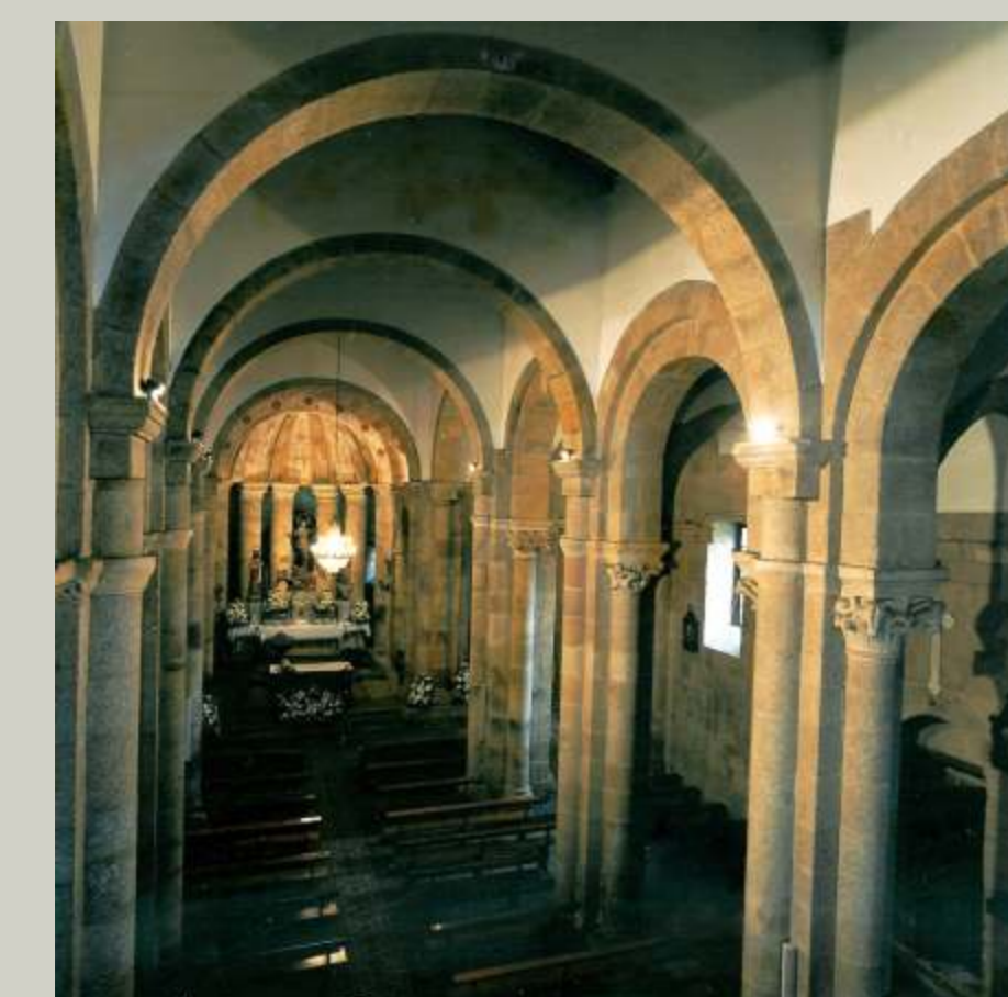
Nave Central. Arcos formeiros, faxóns, peraltados, capiteis vexetais e xeométricos, piares cruciformes... Todo conforma a estrutura arquitectónica interior da igrexa de Cambre.
